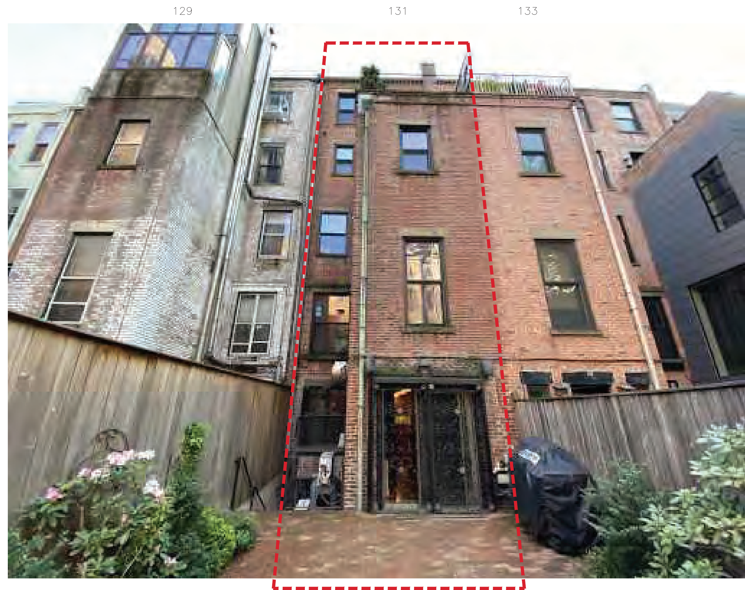
5 131 WEST 69TH STREET-REAR FACADE SCALE: N.T.S.
