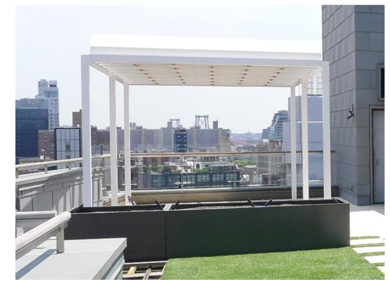
DUE TO ANGLE OF LOUVERS, AT THEIR MOST OPAQUE ANGLE FROM THE STREET, LOUVERS ARE WITHIN 3'-0" ALLOWANCE (REF RENDERS ON A-305)
